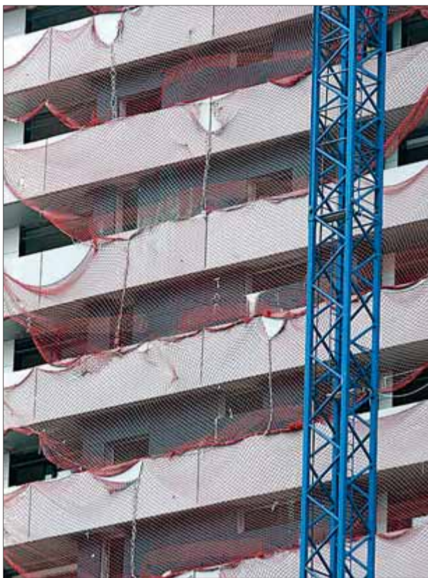
Promoció de pisos en construcció al barri del Poblenou de Barcelona ■ MIQUEL ANGLARILL/ARXIU
